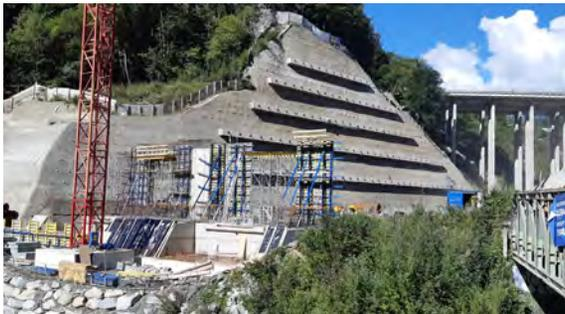
Bauzustand Südportal Vortunnel „Silltal“; davor Widerlager für Eisenbahnbrücken über die Sill, dahinter Hanganschnitt für offene Bauweise
